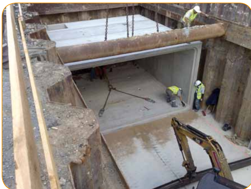
▲ Construction d'un bassin pour lutter contre les débordements à Vanves
