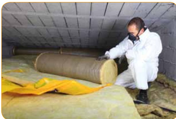
◀ Travaux d'isolation de toiture
